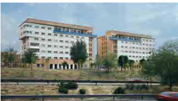
VIVIENDAS SOCIALES EN MADRID M-30
