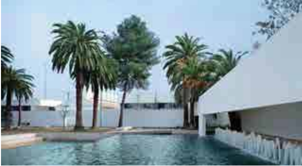
AYUNTAMIENTO DE TOMARES, SEVILLA REHABILITACIÓN DE LA HACIENDA SANTA ANA
