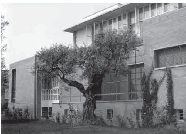
CASA UHTNA-HUS, MAIRENA DEL ALJARAFE, SEVILLA
